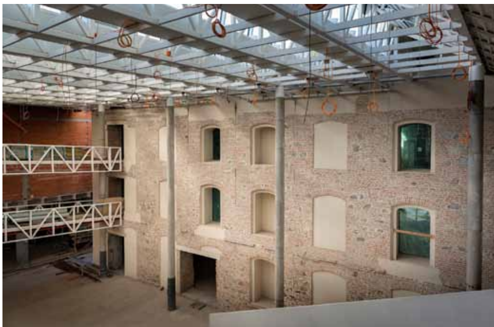
Rekonstrukce SNG v Bratislavě, stav v roce 2019, foto: Martin Deko
