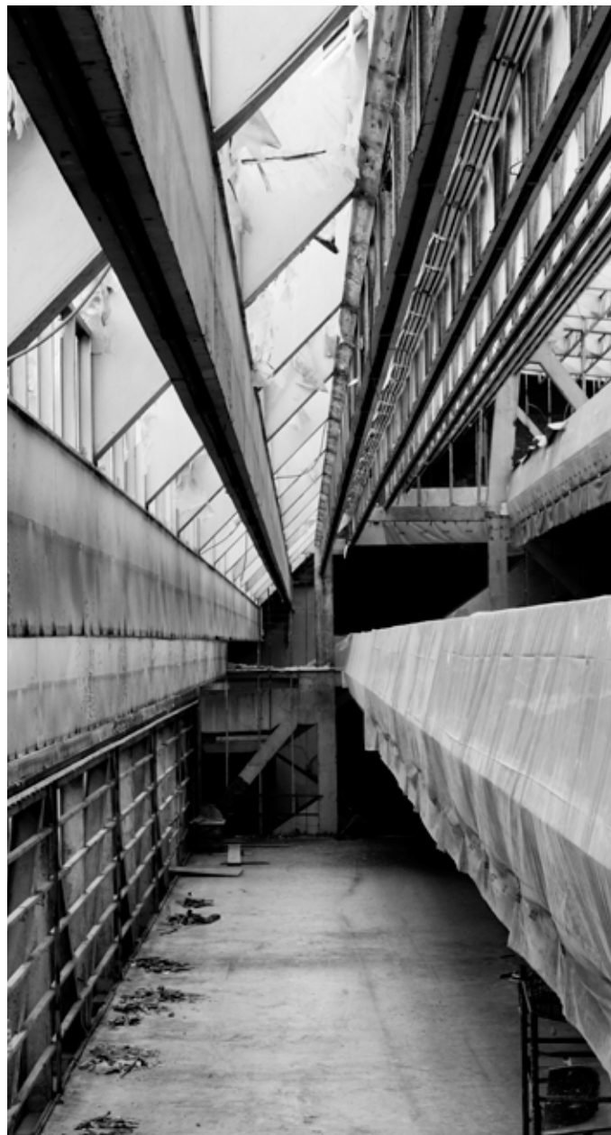
Rekonstrukce SNG v Bratislavě, stav v roce 2017, foto: Martin Deko
