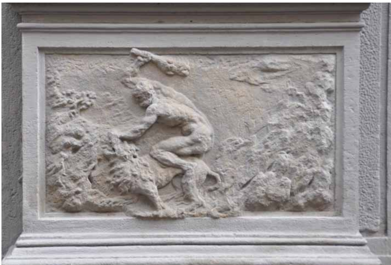
Druhotný pokus o ztenčení vrstvy fasádního nátěru s prosvítajícími plochami dochovaného povrchu kamene u jednoho z reliéfů, foto © Viktor Kovařík
