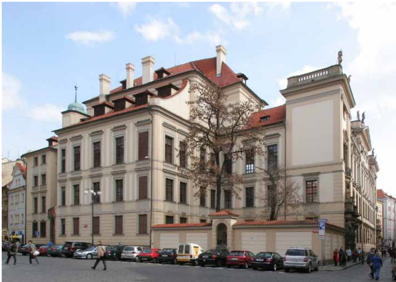
Clam-Gallasův palác před rekonstrukcí, foto © Martin Mádl
