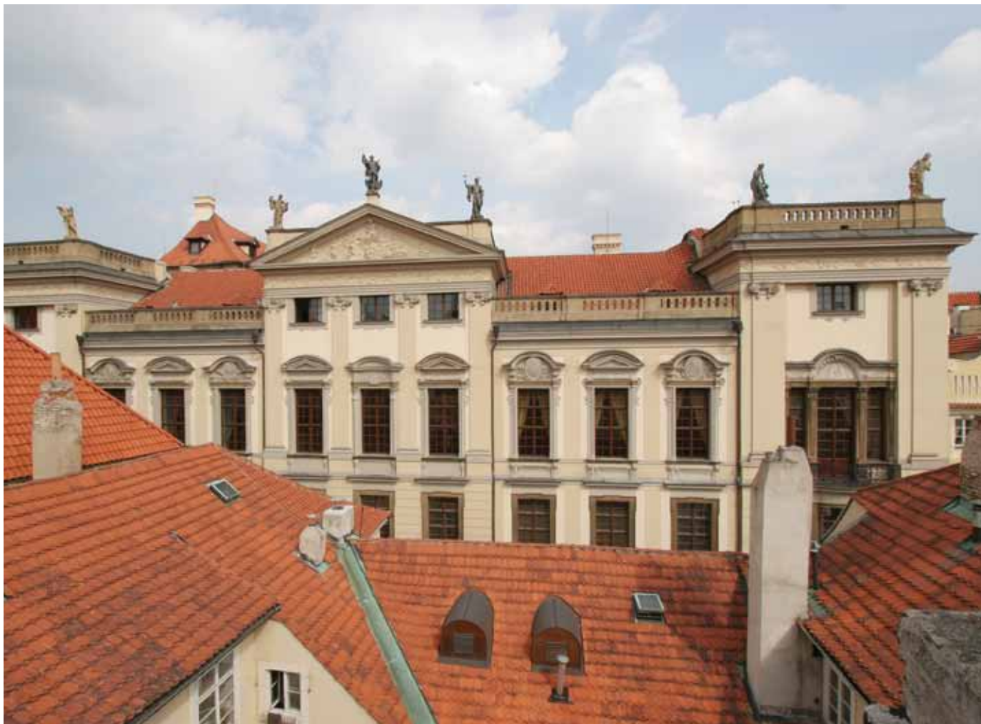
Průčelí Clam-Gallasova paláce před rekonstrukcí, foto © Martin Mádl
