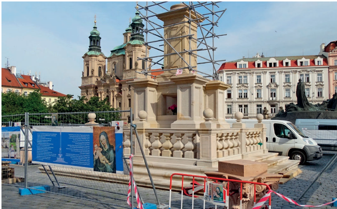
Dokončení obnovy Mariánského sloupu 5. 6. 2020, foto: Josef Čermák, marianskysloup.cz
