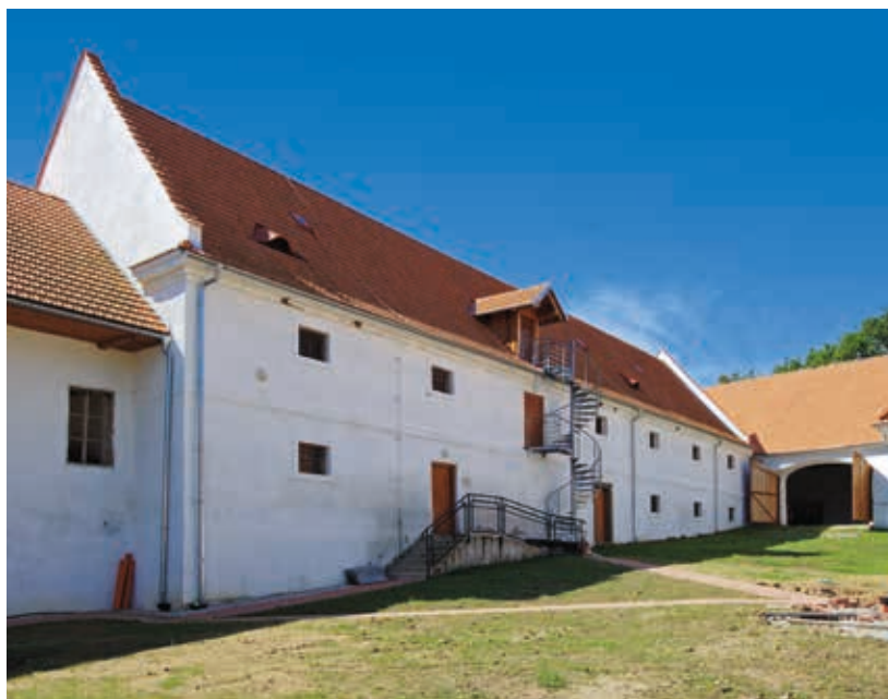
232. Skočice, sýpka hospodářského dvora, pohled od severu, foto 2020
