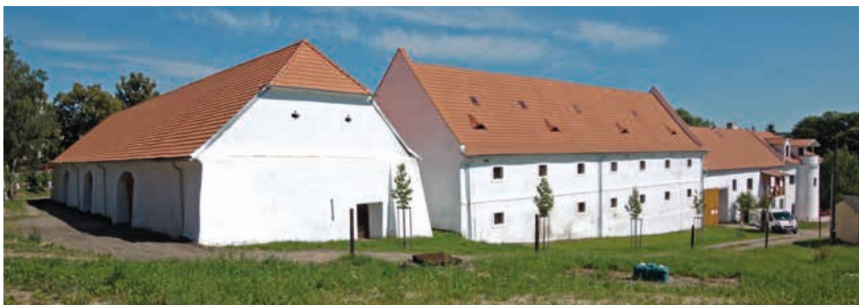
234. Sokočice, areál hospodářského dvora se sýpkou uprostřed, pohled od jihu, foto 2020
