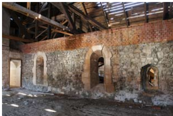
Obr. 5. Hospodářský dvůr kláštera Plasy, pohled do interiéru
