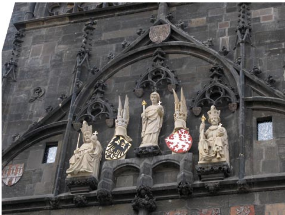
1. Tesané kopie parléřovské tesařské výzdoby Staroměstské mostecké věže. Protože se nepočítá s razantním přečištěním průčelí, jeví se dodatečná umělá patinace jako nezbytná.
