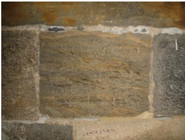
4. Příklad středověké, poměrně velké spáry s úlomky břidlice, vtlačenými do ložné malty, v průjezdu Staroměstské mostecké věže.
