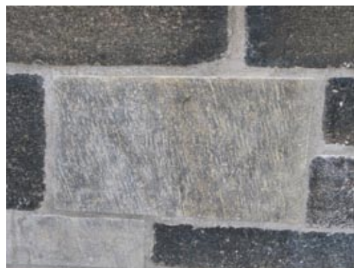
3. Příklad ručního povrchového osekání a patinace vyměněného kvádrů.
