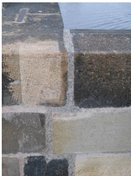
2. Příklad vyplnění dilatační spáry silikonovým tmelem s přidáním jemné kamenné drti.
