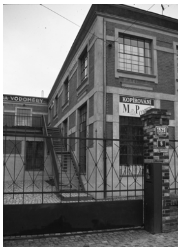
Bývalá továrna Adolfa R. Pleskota, Praha 7 – Holešovice, dnešní stav
