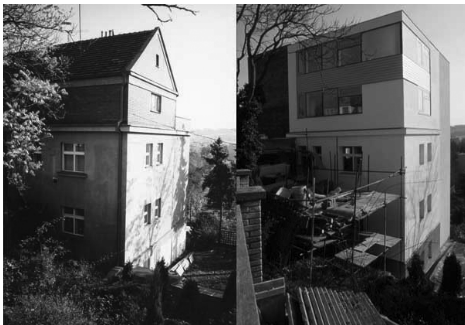
Činžovná vila Xaveriova, Praha 5 – Smíchov, stav před přestavbou
