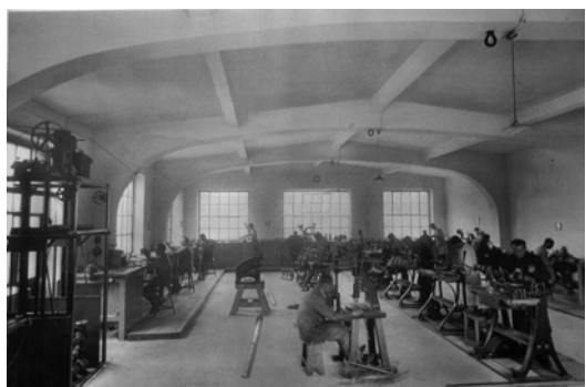
Továrna Adolfa R. Pleskota, hala pro montáže vodoměrů, stav kolem roku 1938
