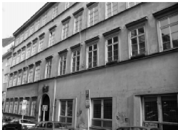
Zbořený dům čp. 1277/II ve Vodičkově ulici
